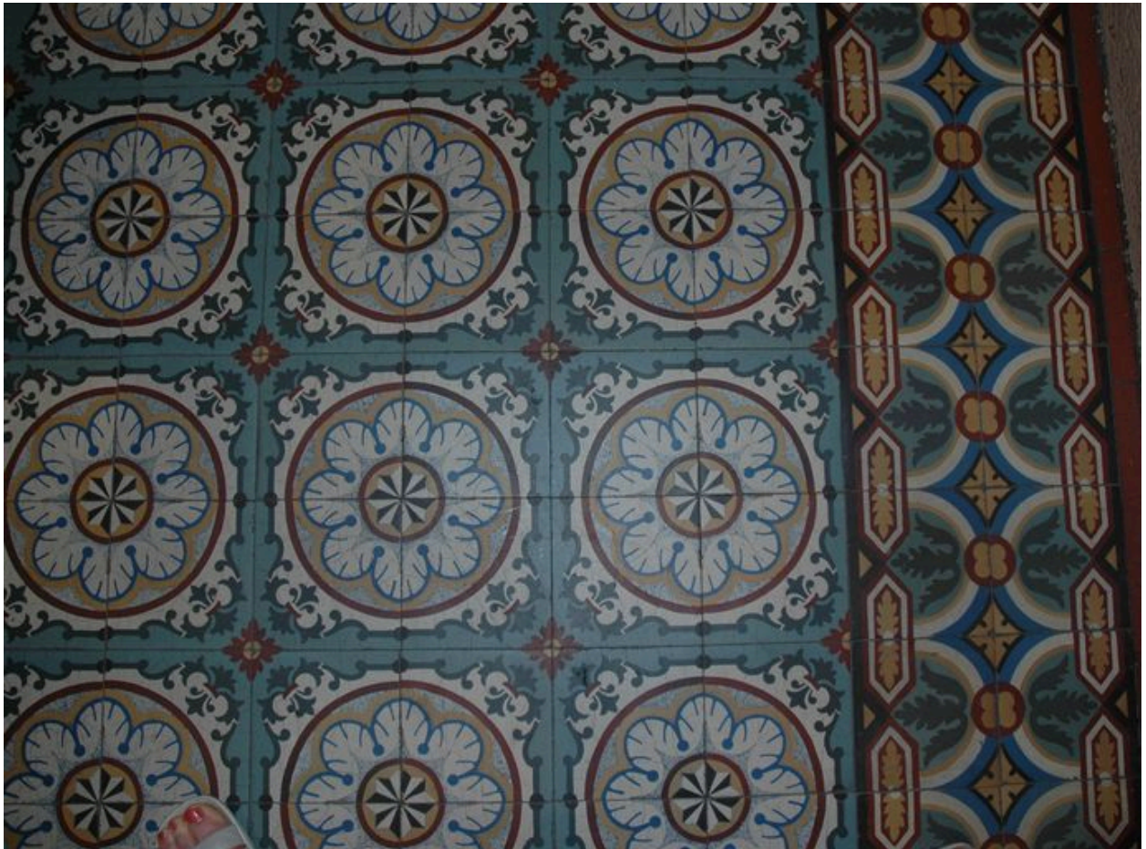
Détail du carrelage du vestibule
