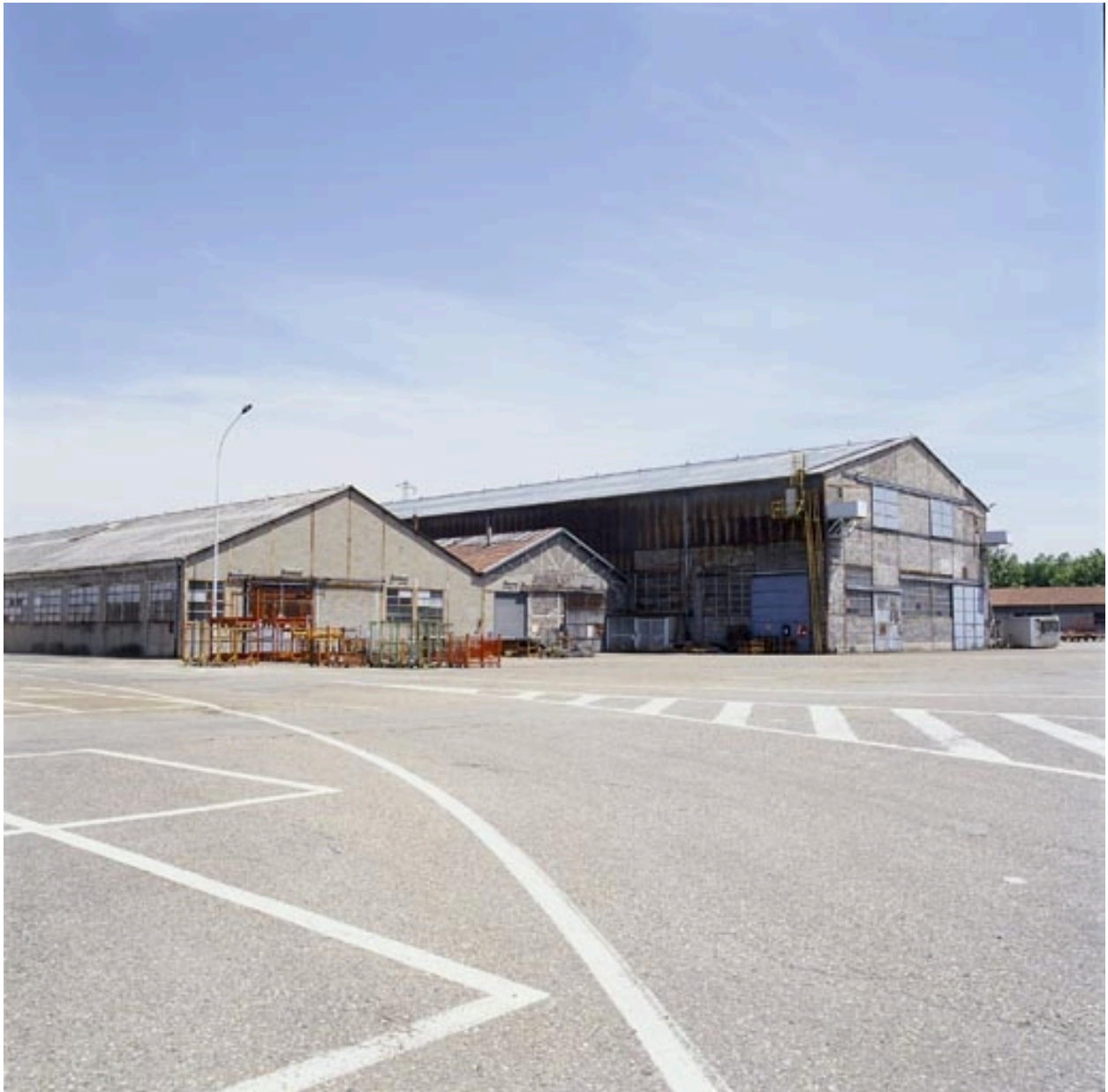
CDIPR, bâtiments C19, 23, 25, anciens bâtiments de stockage.
