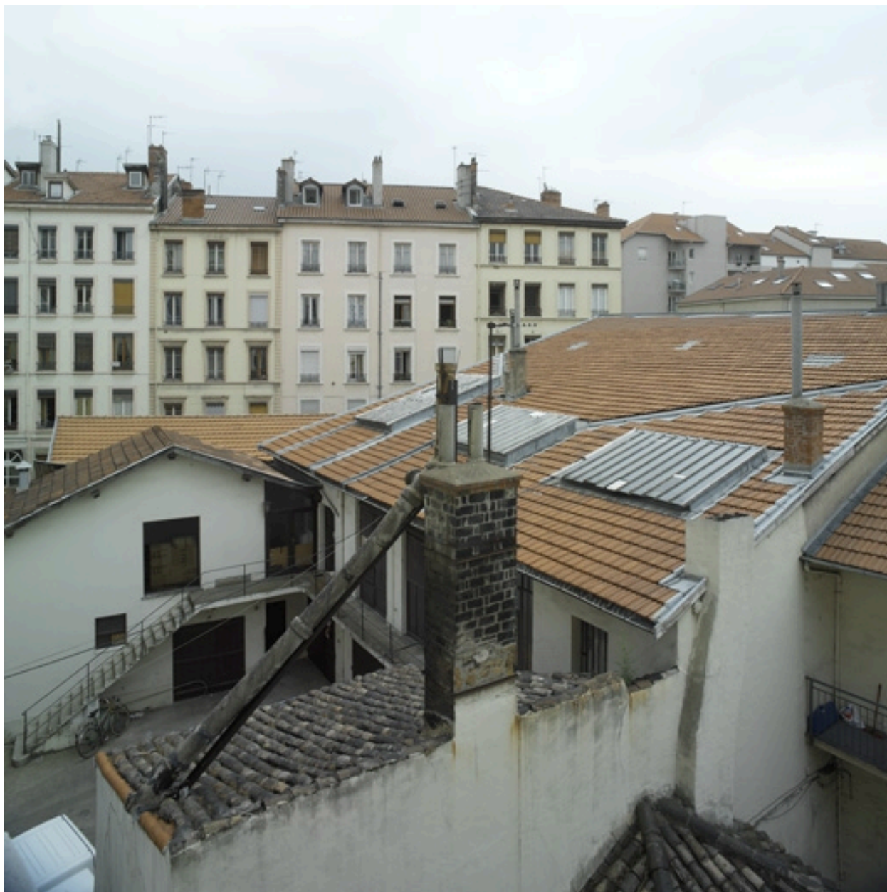
Vue d'ensemble et détail toiture des ateliers
