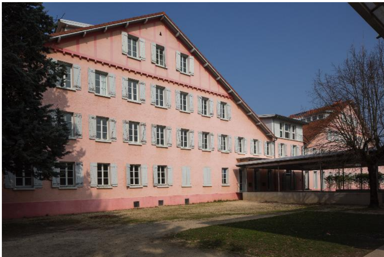
Bât. A : façade sud-est de l'aile est avec passage C
