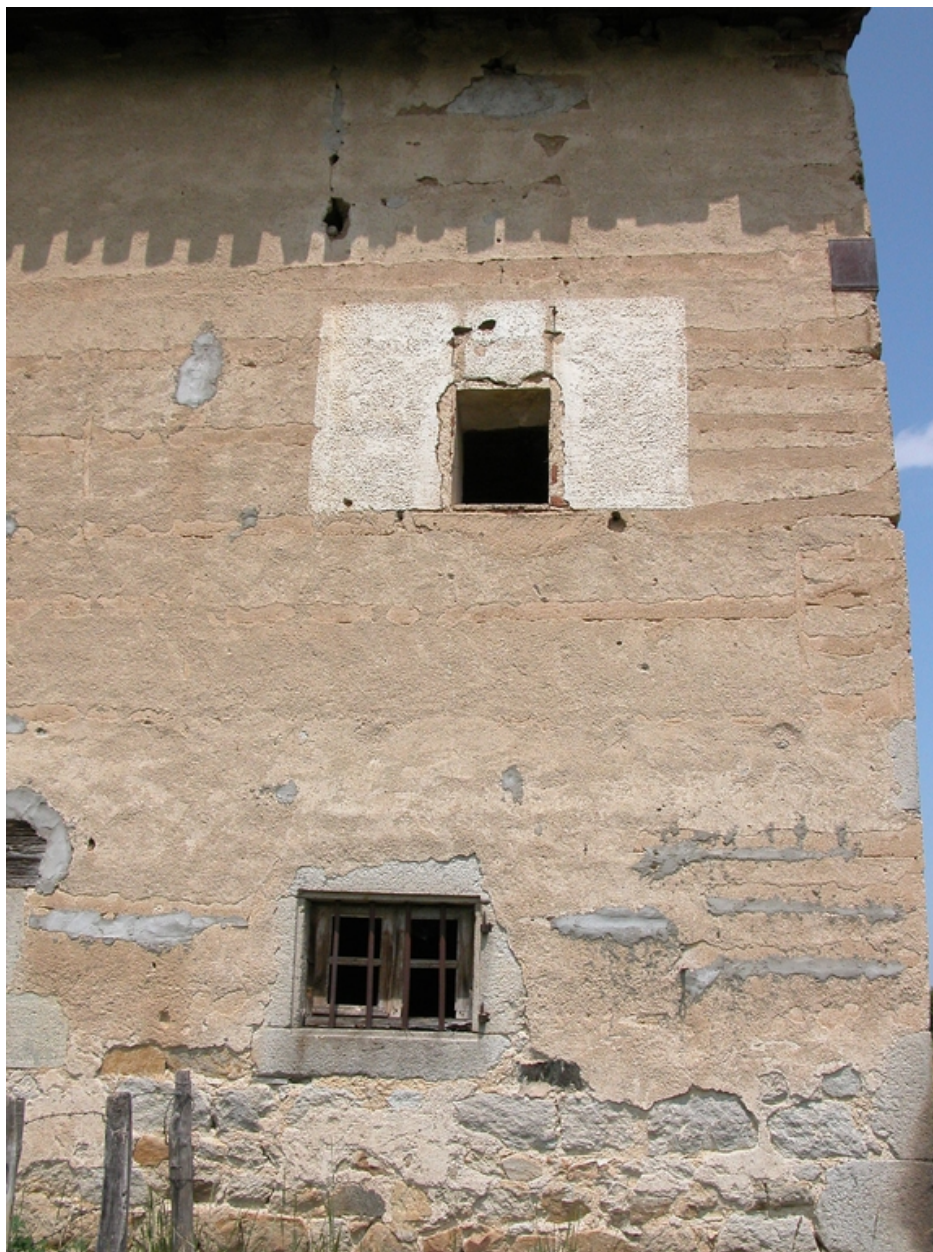
Détail de la fenêtre du pigeonier.
