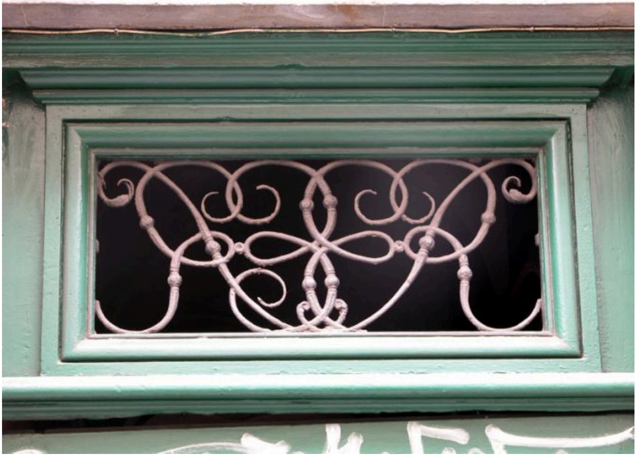
Façade principale, porte, détail du tympan de menuiserie
