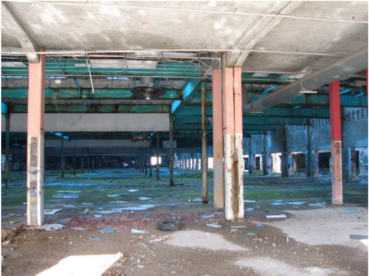
Jonction de la façade principale et des ateliers shed localisé sur l'arrière du bâtiment principal à étages
