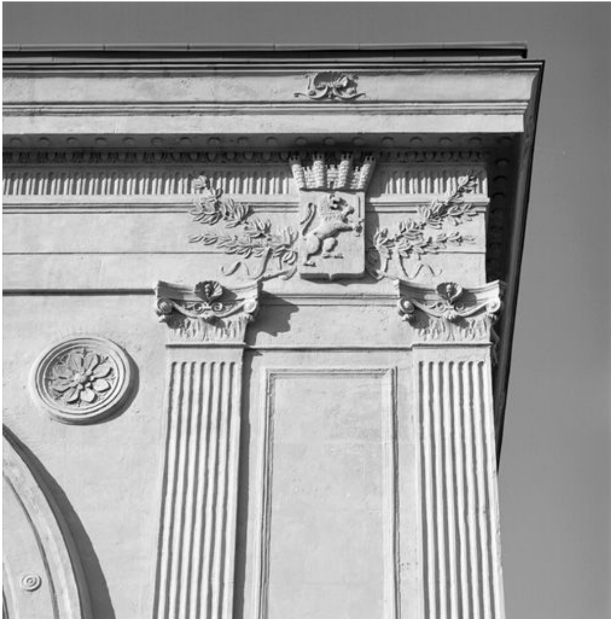
Le bâtiment-voyageurs : corps de bâtiment central, élévation nord, détail du décor architectural
