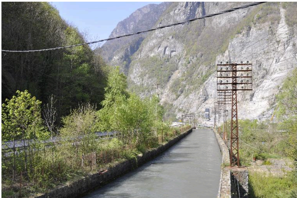
Vue du canal de Rioupéroux
