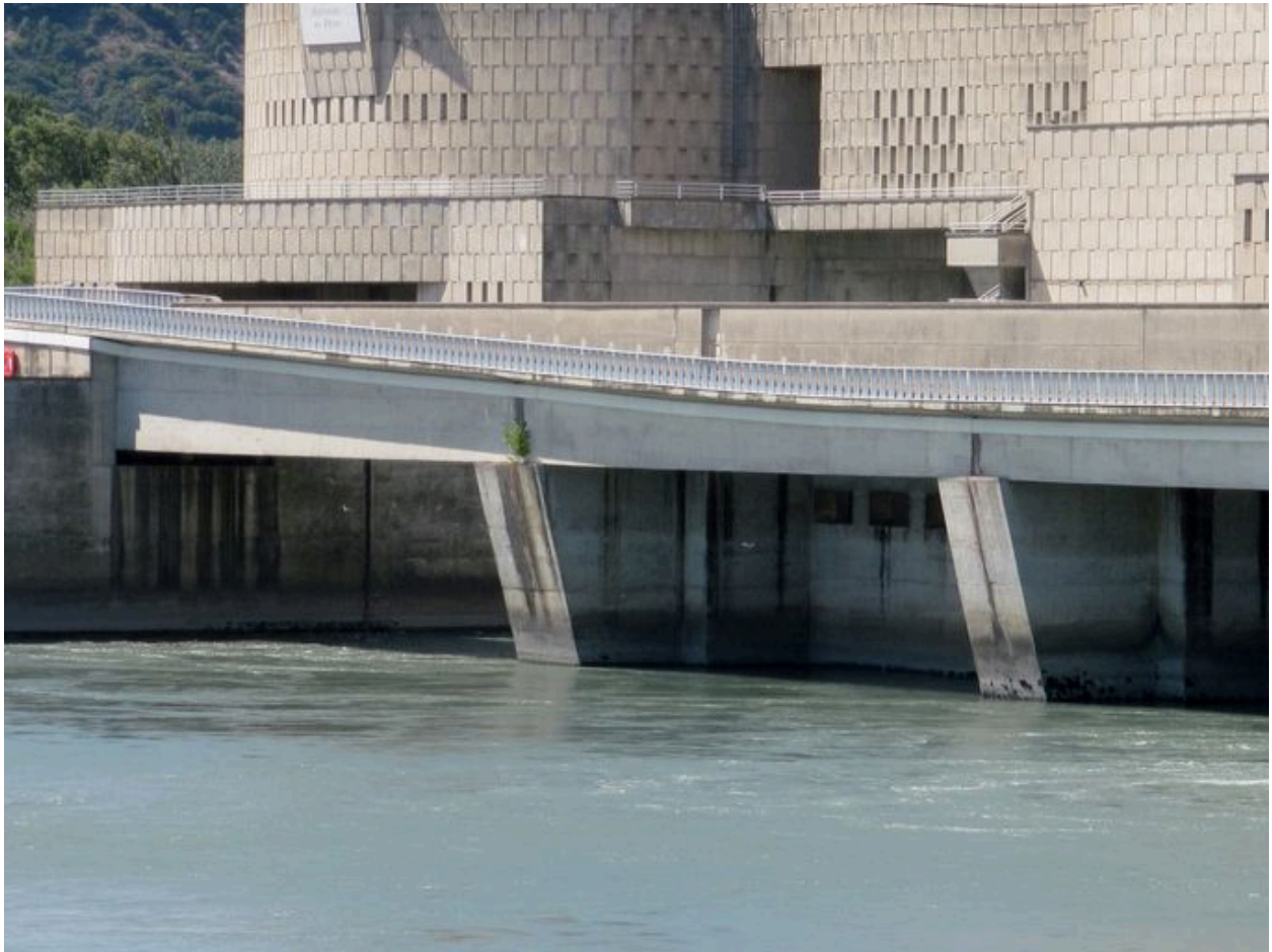
Pont routier, vue partielle (depuis la rive gauche)
