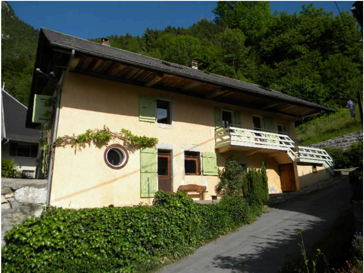
Vue de la façade est d'une ancienne ferme (2008 B5 885,886)
