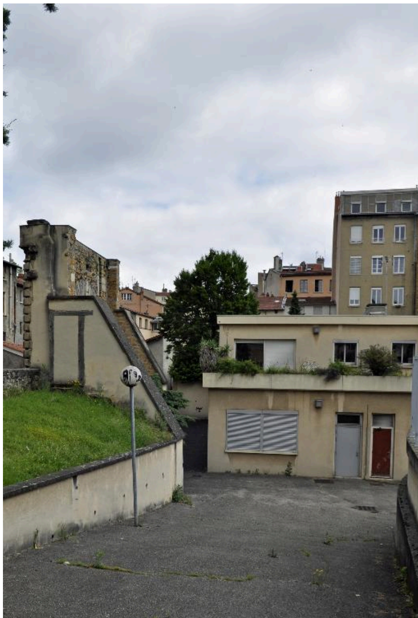
Vue partielle de l'élévation sud : étage de soubassement couvert d'une terrasse
