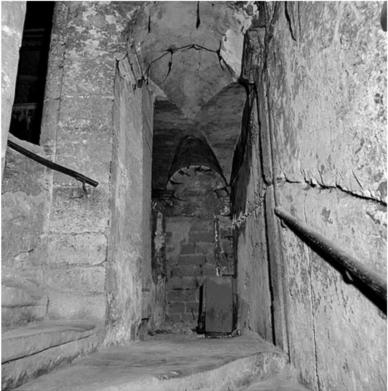
Galerie voûtée d'arêtes au premier étage conduisant aux appartements
