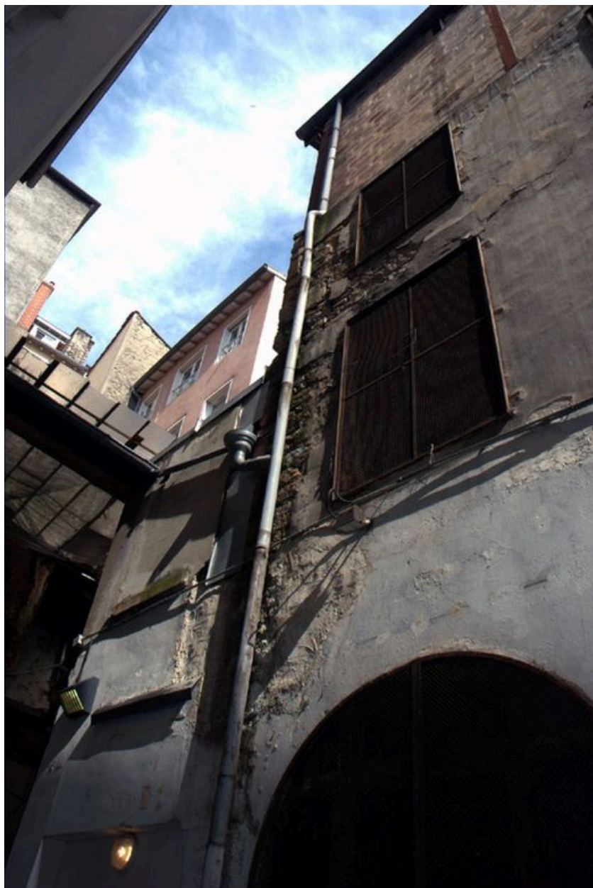
Elévation postérieure de la salle de cinéma, détail de l'angle ouest
