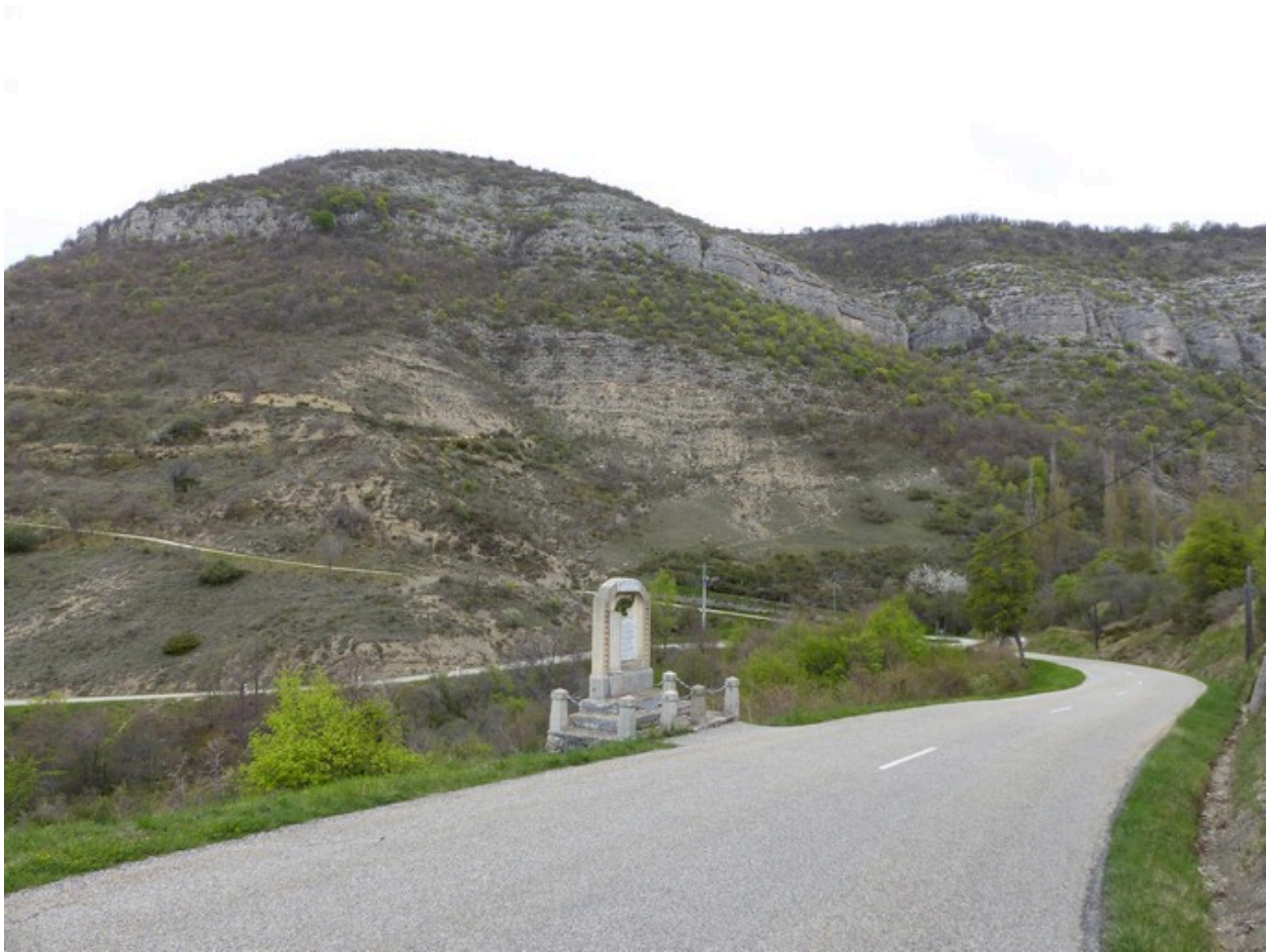
Vue de situation prise du sud-est.
