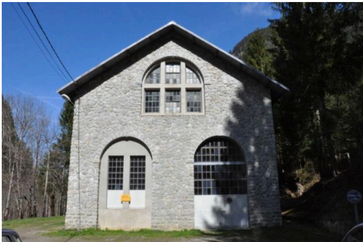
Pignon sud-est de la centrale.
