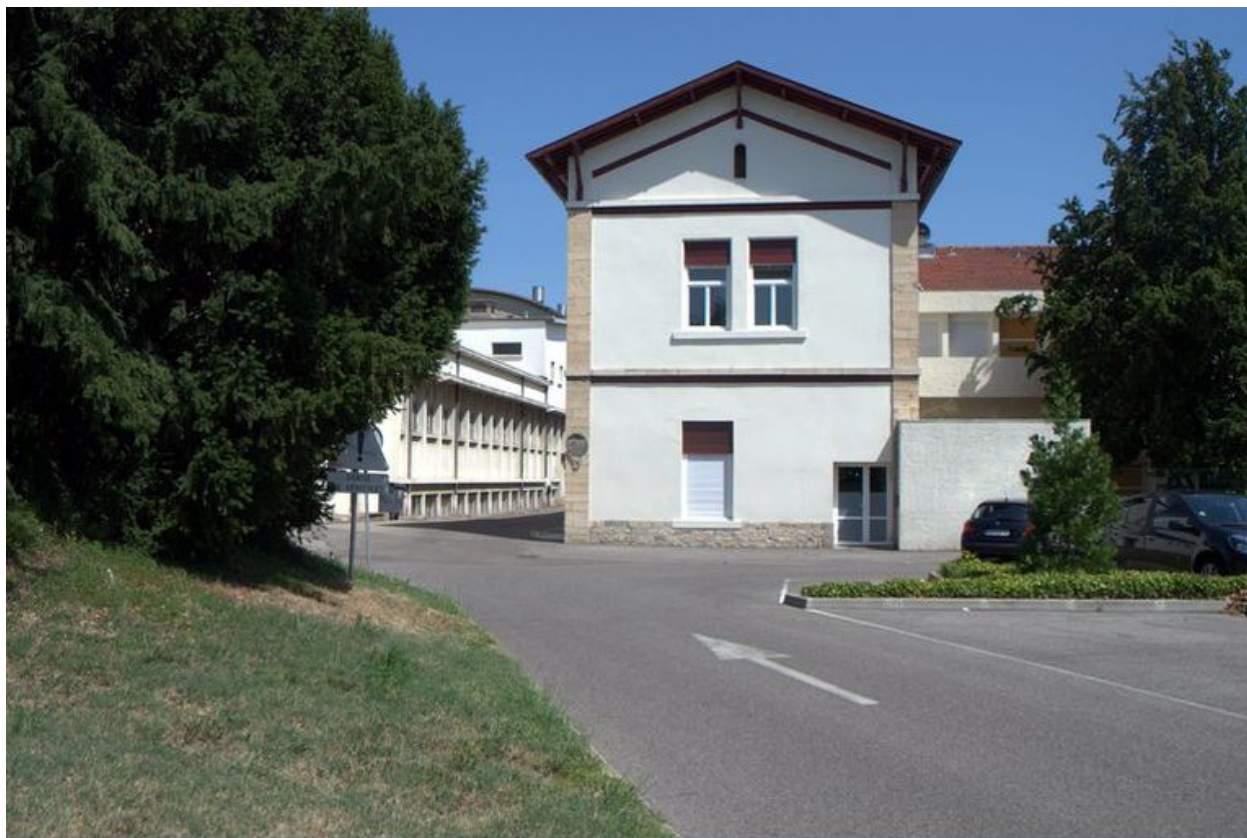
Aile nord depuis l'ouest
