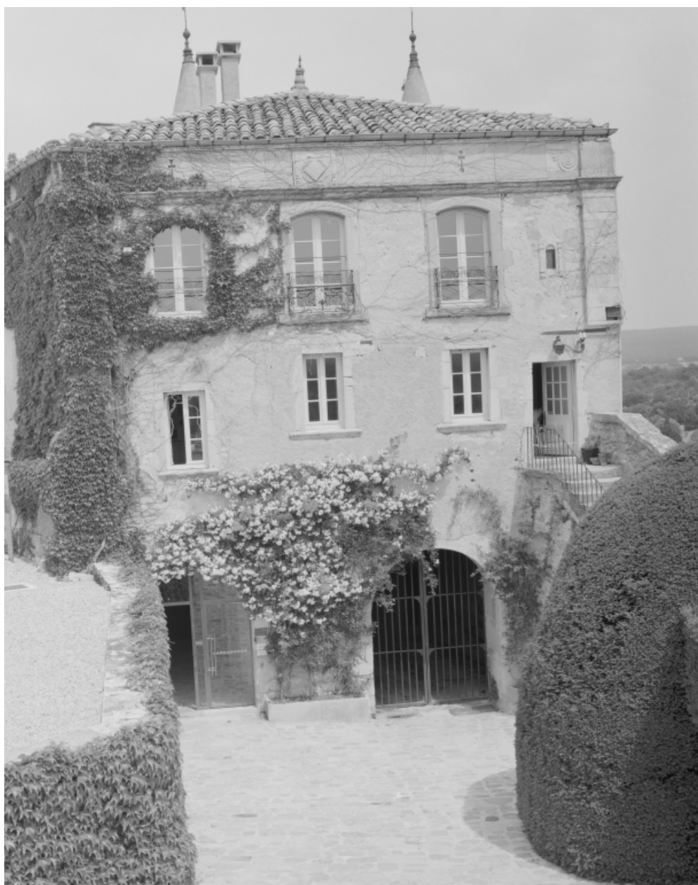
Bâtiment d'entrée. Vue d'ensemble de la façade sud.
