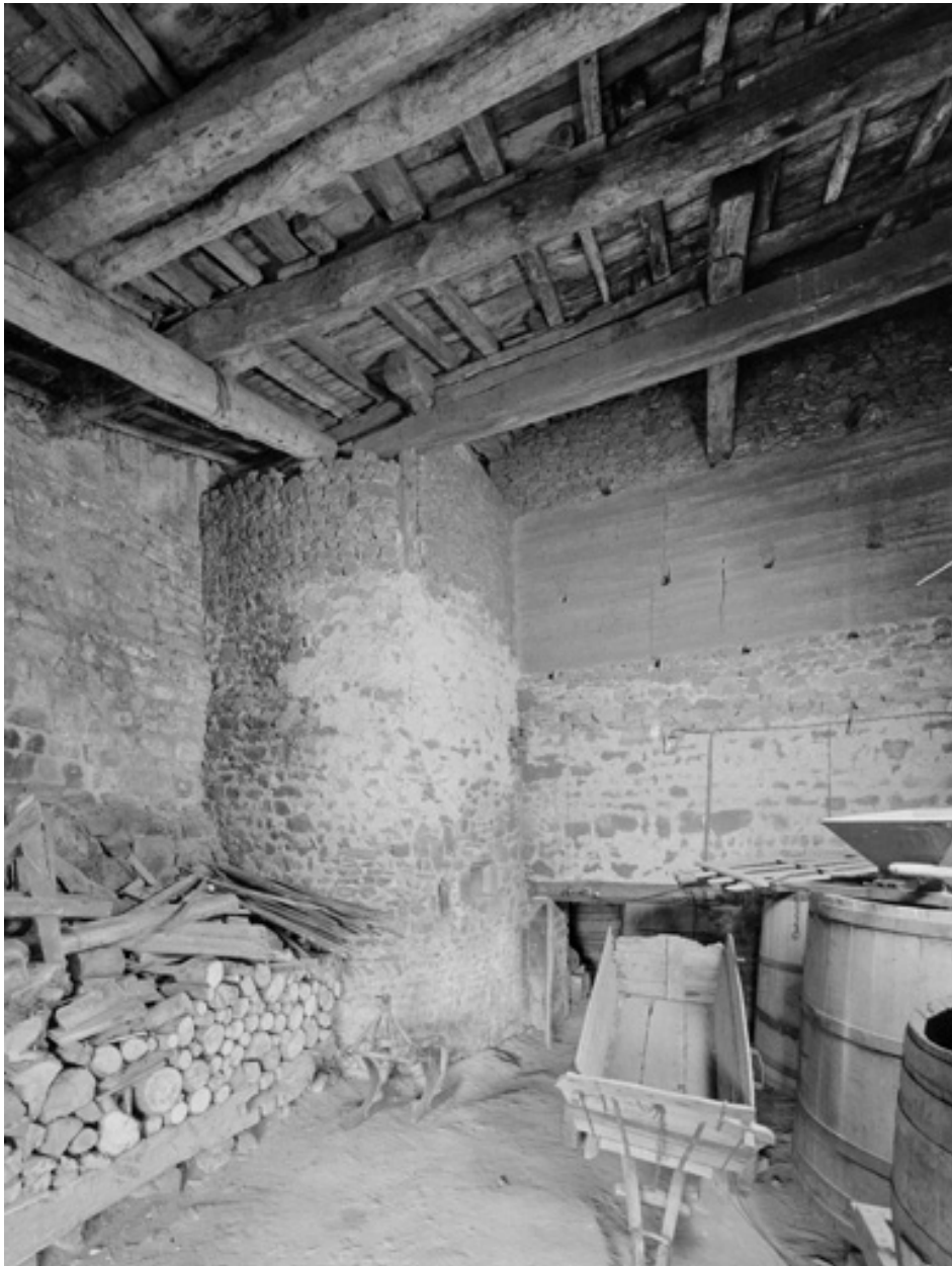
Vue intérieure du cuvage.
