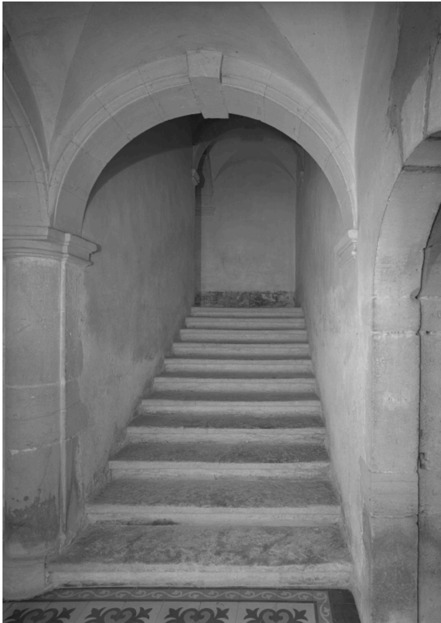
Escalier de l'aile gauche, 1ère volée.
