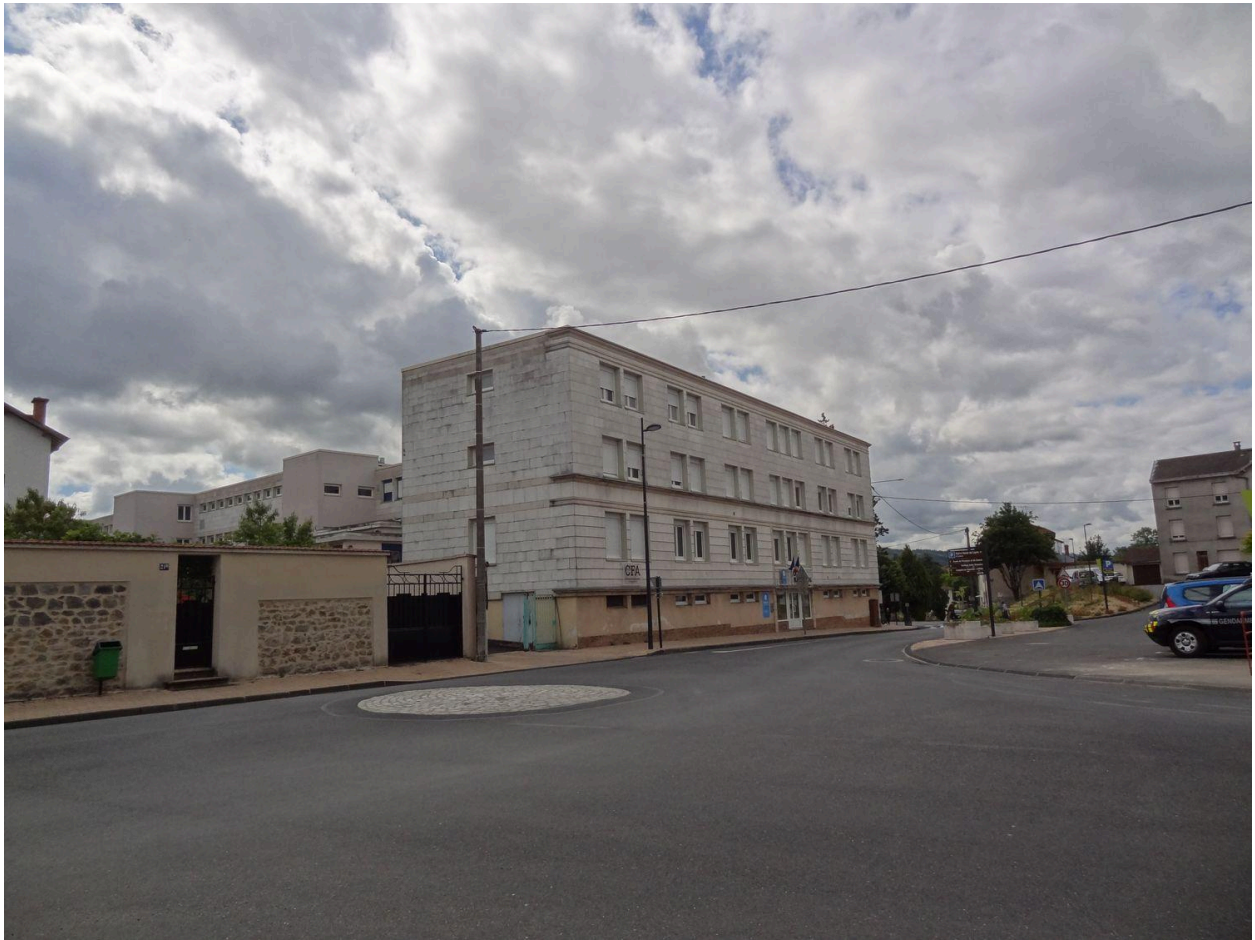
Vue du bâtiment de l'administration et des logements de fonction.
