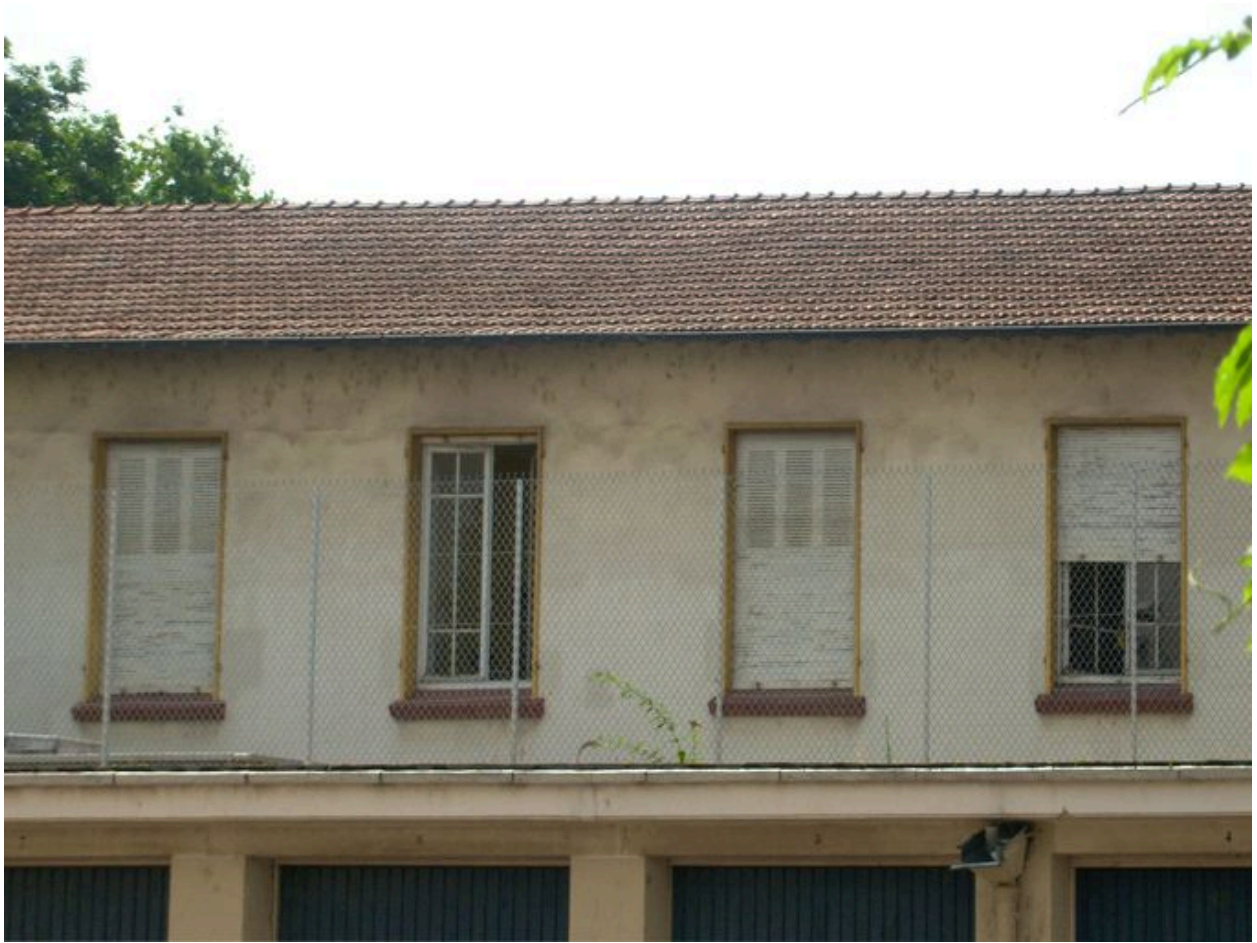
Bâtiment Nord Ouest, vue sur l'étage de l'élévation Sud
