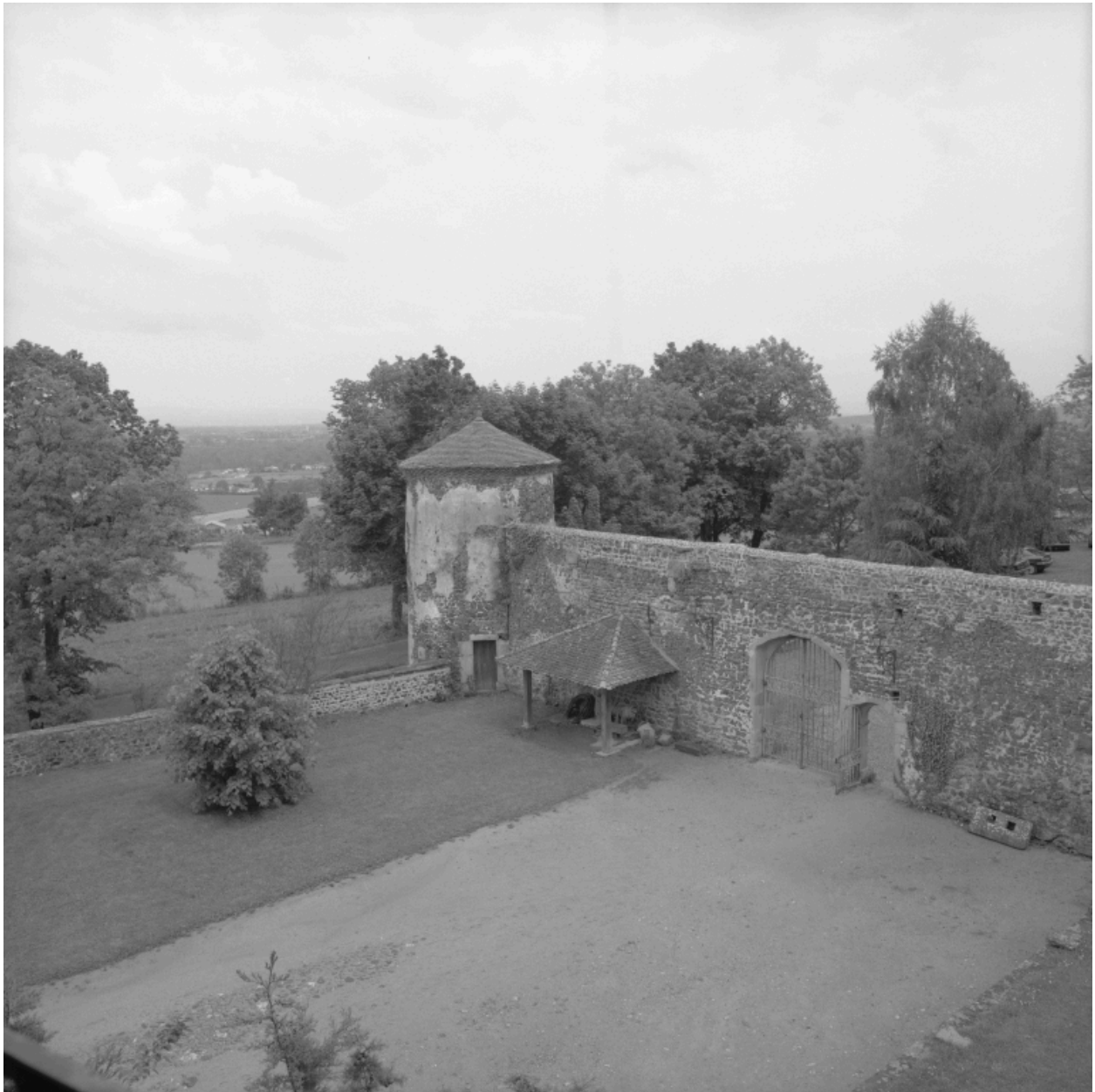
Vue générale intérieure de la cour d'honneur (tour d'enceinte est et portail de l'entrée principale), de l'ouest.
