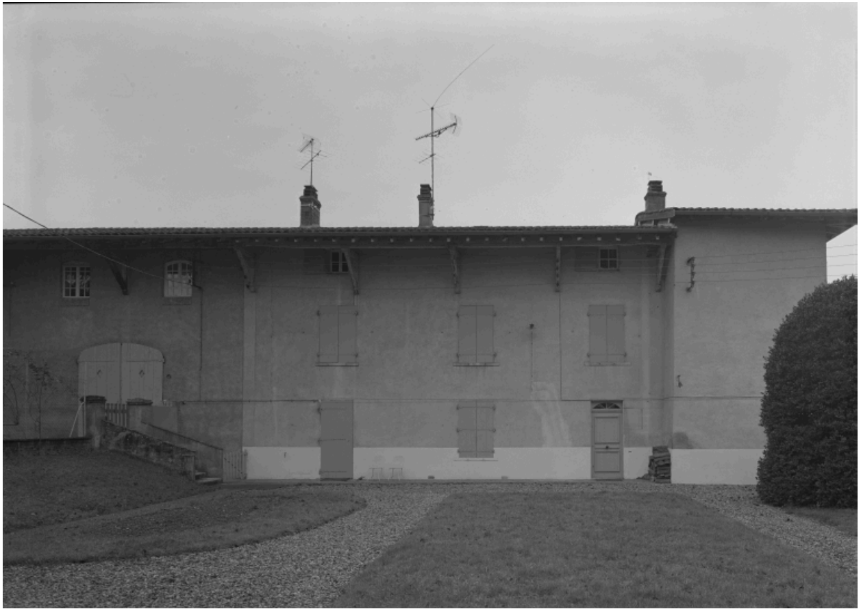
Vue partielle sur l'élévation principale : le logis de maître.
