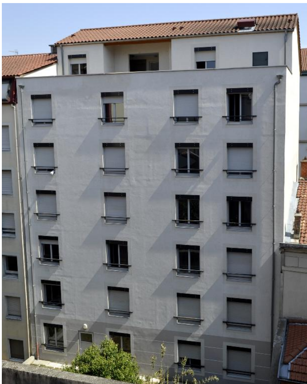
Vue générale de l'élévation postérieure
