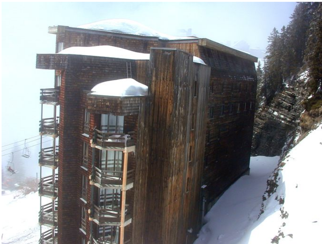
Façade postérieure, vue depuis le sud-est
