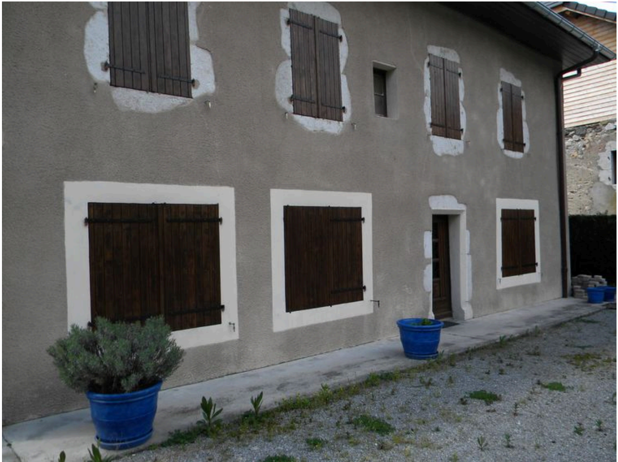
Vue du pignon est.
