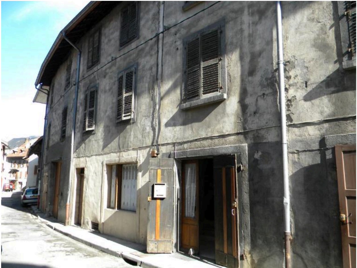
Vue d'ensemble de la façade principale sur rue.
