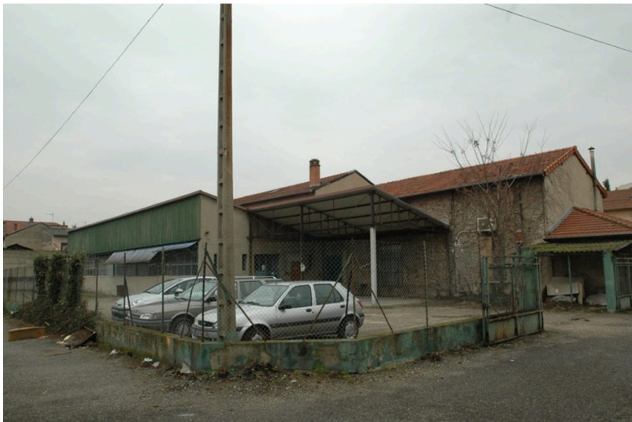
Vue sur la cour, angle sud ouest.
