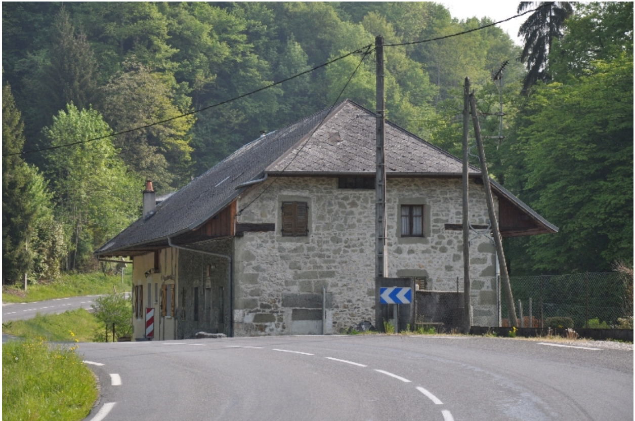
Vue générale du moulin, façade sud-ouest.
