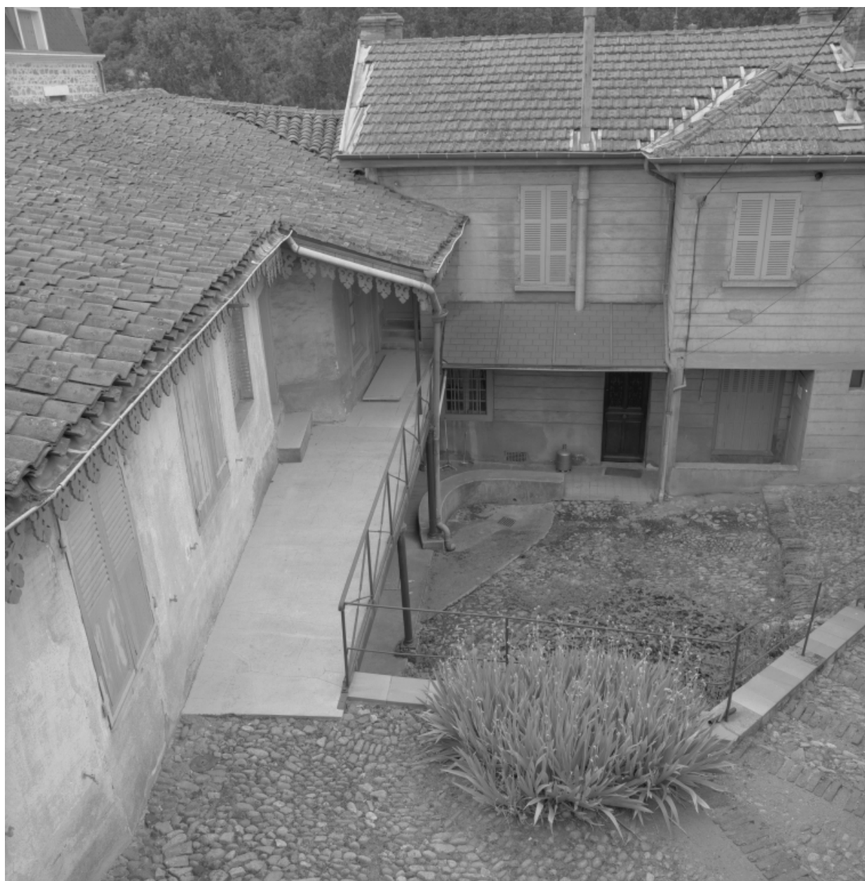
Maison, 8, place Saint-Vincent. Vue des bâtiments sur cour, du nord-est.
