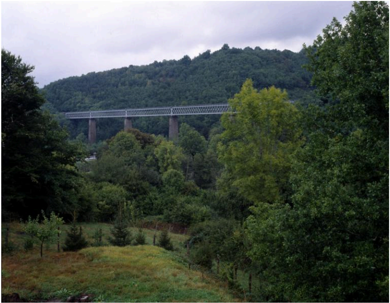
Un des ouvrages d'art de la ligne : le viaduc de la Sumène, sur la commune de Bassignac.
