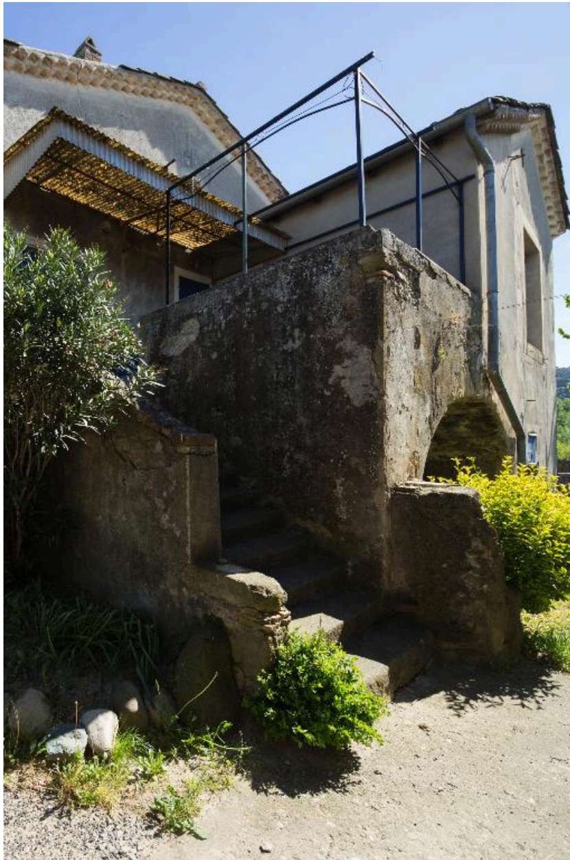
Maison : façade ouest, accès par escalier
