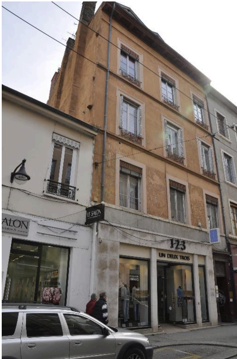
Vue de la partie nord de l'immeuble
