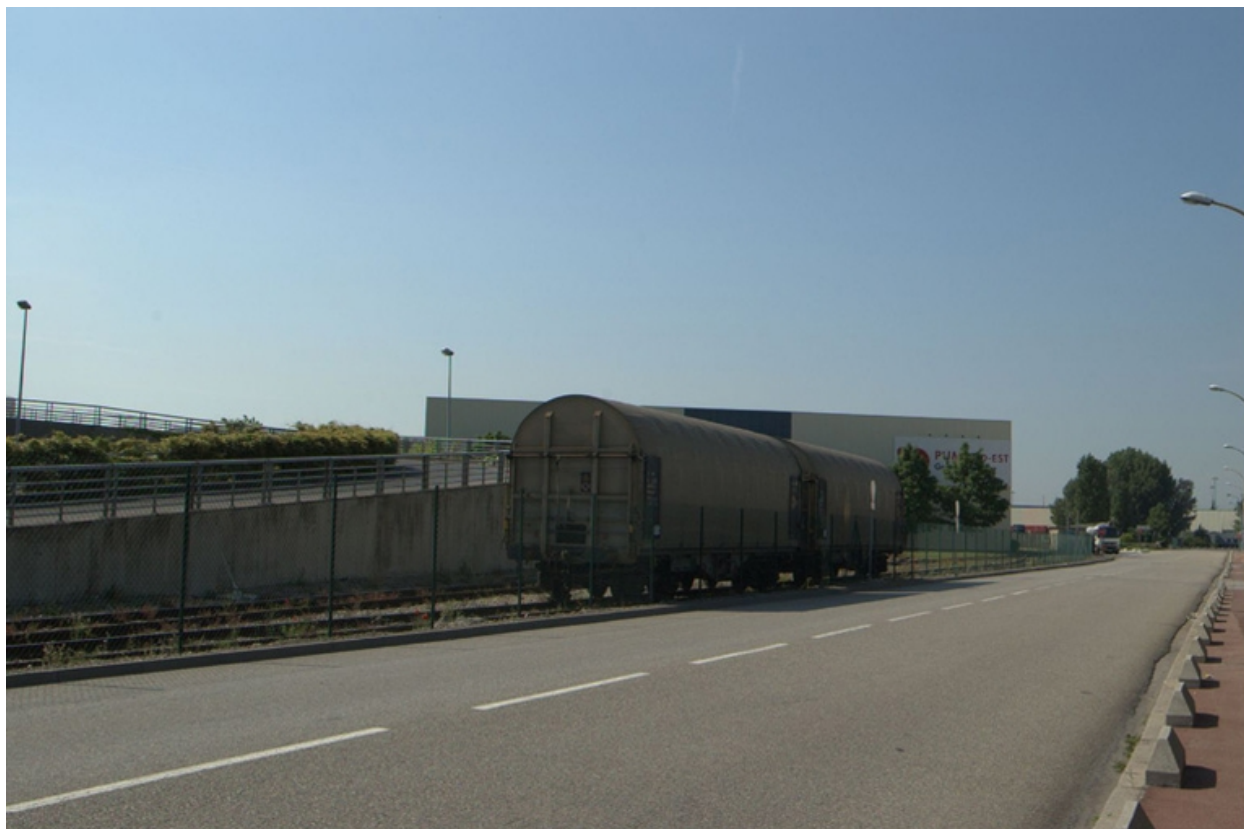
Raccordement ferroviaire intra-muros du port
