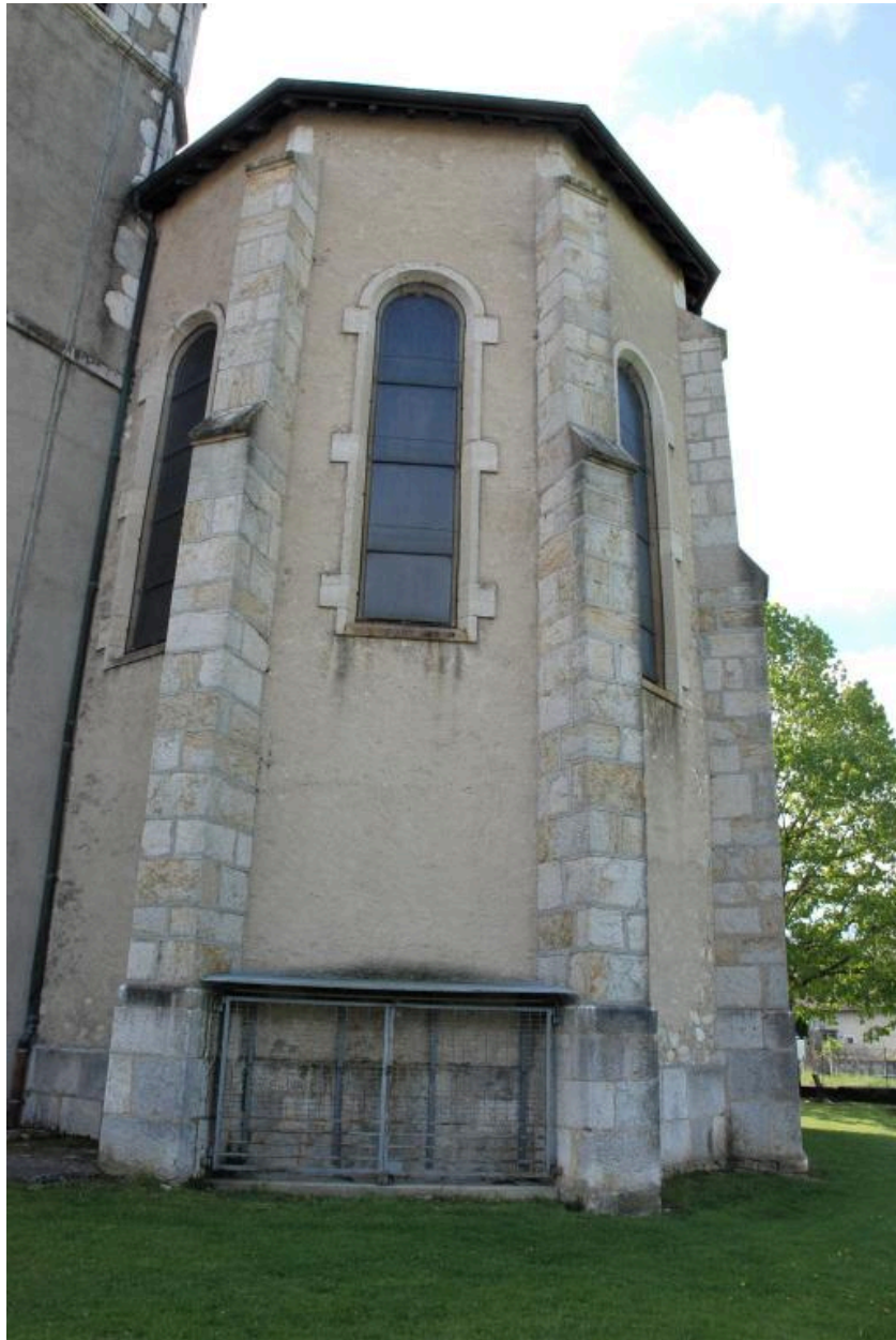
Détail nord du chevet de l'église
