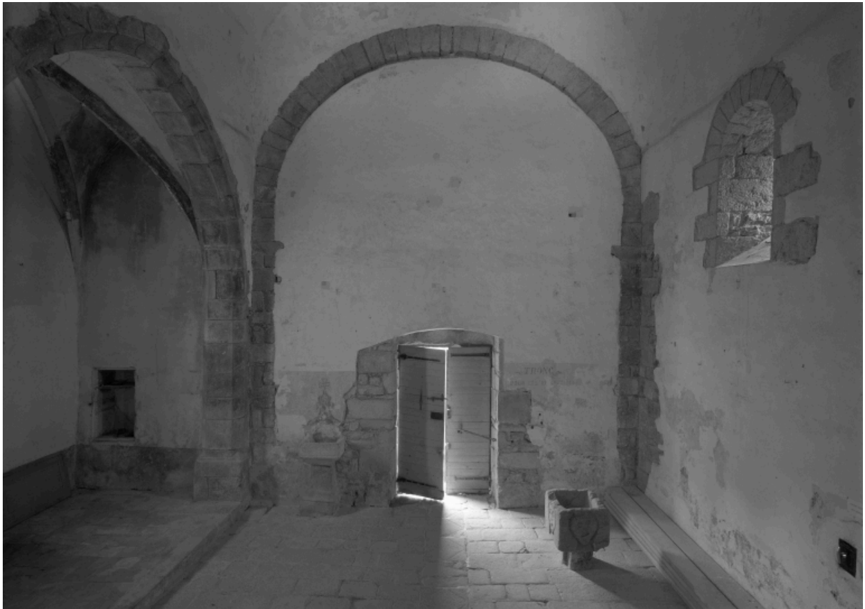
Vue générale intérieure de la chapelle, vers l'ouest.
