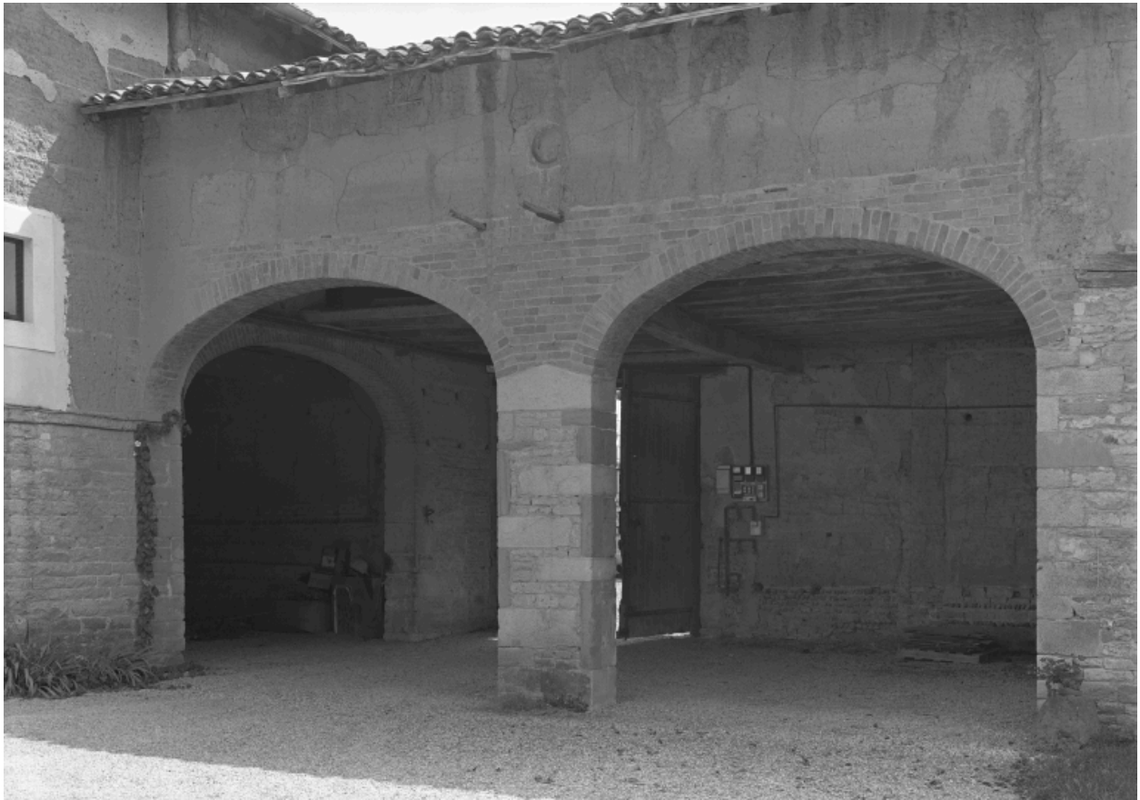
Corps de porche sud, vue prise de la cour.
