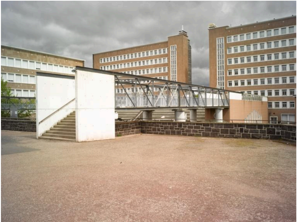
Vue depuis la cour vers l'est : bâtiments d'internat, et passerelle avec salle de restaurant de la campagne de travaux due à l'agence Fabre et Speller.
