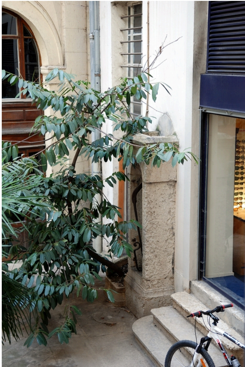
La cour, côté sud : le puits
