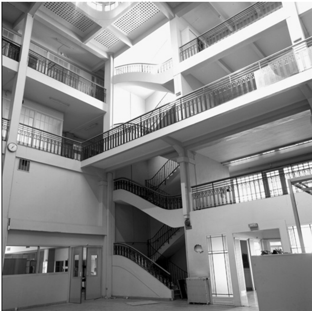
Cage d'escalier nord
