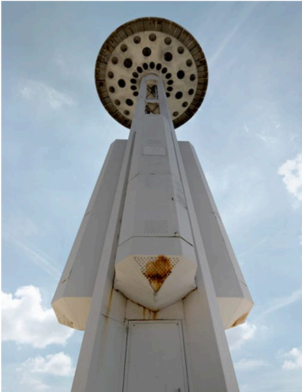
Partie sud de la piscine : détail d'un pylône (état en juin 2012).
