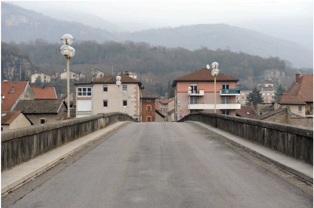
Vue générale, de dessus, chaussée (depuis la rive gauche)
