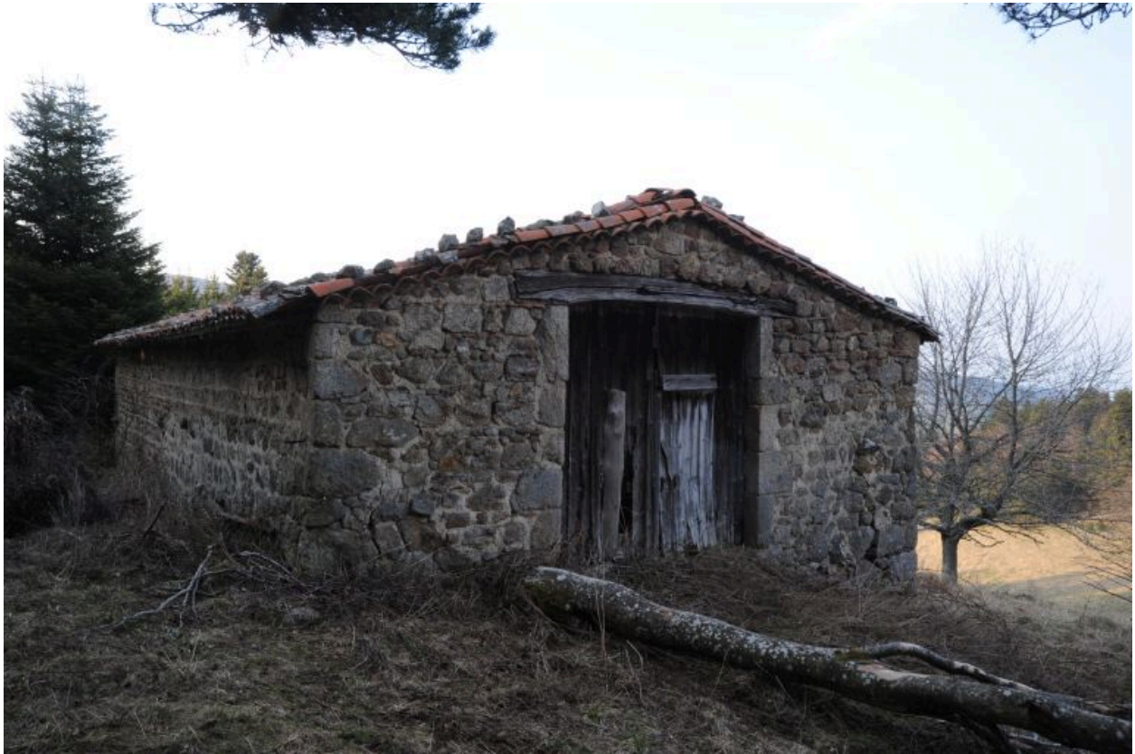
Vue d'ensemble de trois quarts sud-ouest
