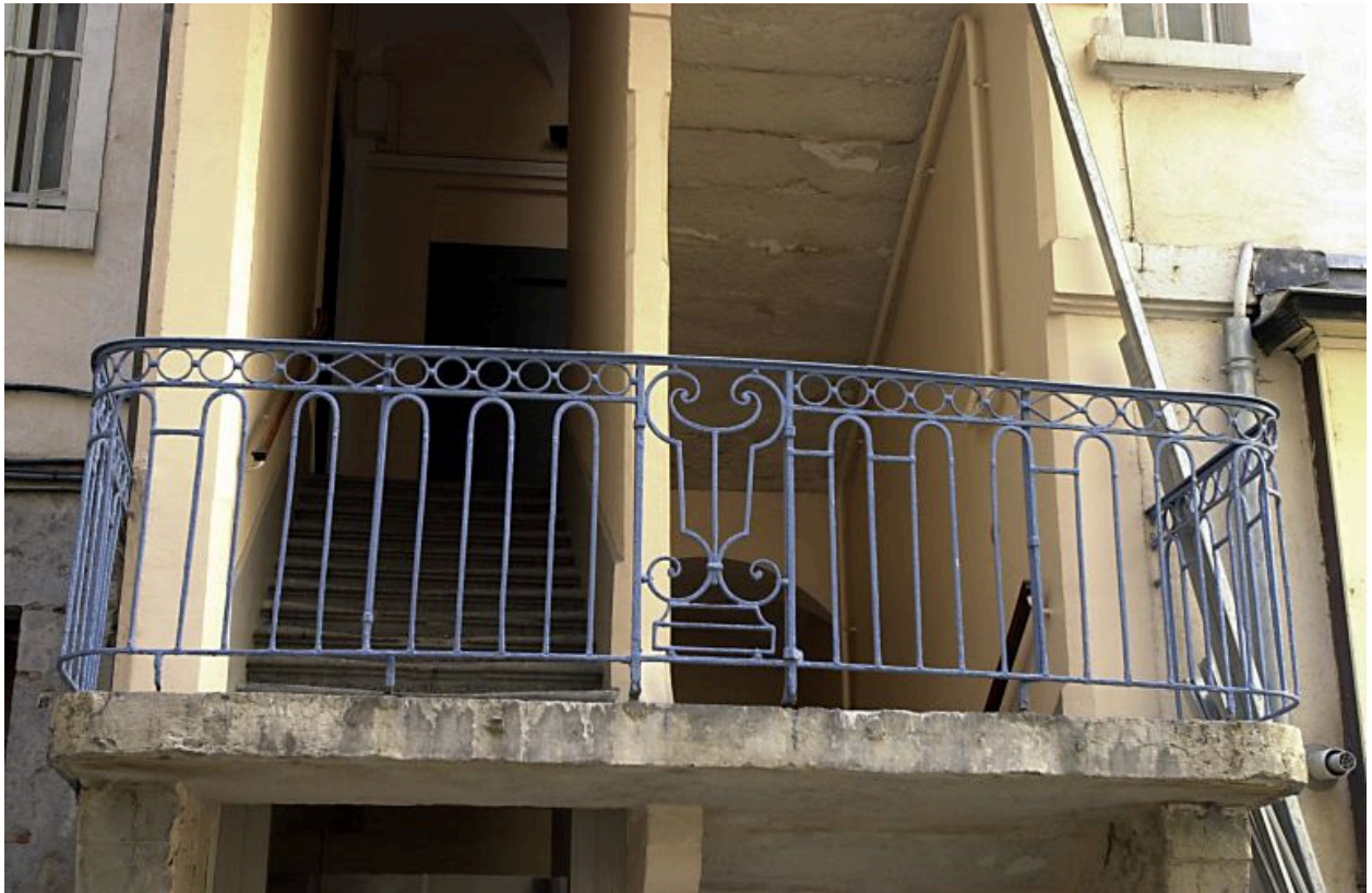
Escalier de la 2e cour, détail du garde-corps du 1er repos
