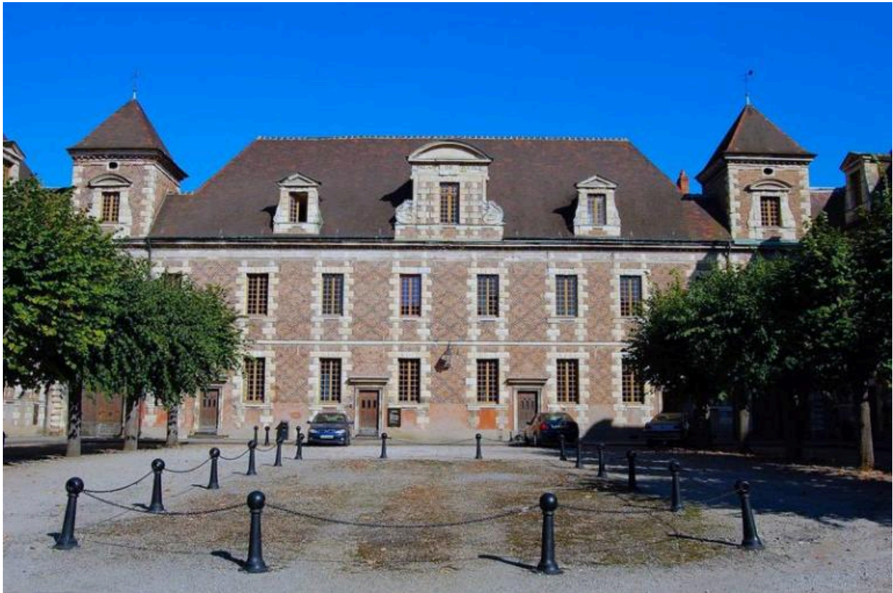
Vue d'ensemble de l'élévation principale
