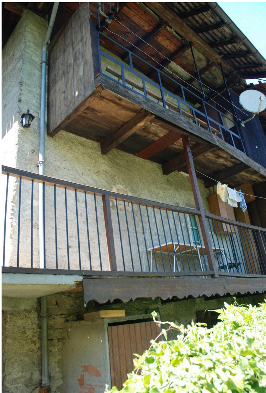
Maison de vigneron, ferme à juxtaposition (2018 I1 1297), vue sud-est : pignon du logis.
