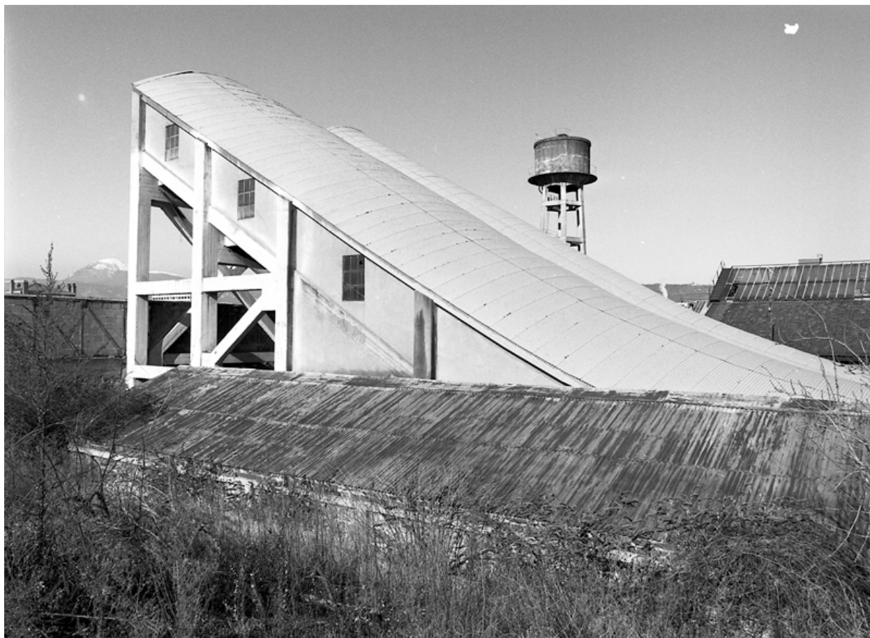
Pistes d'essais en 2005, avant destruction.
