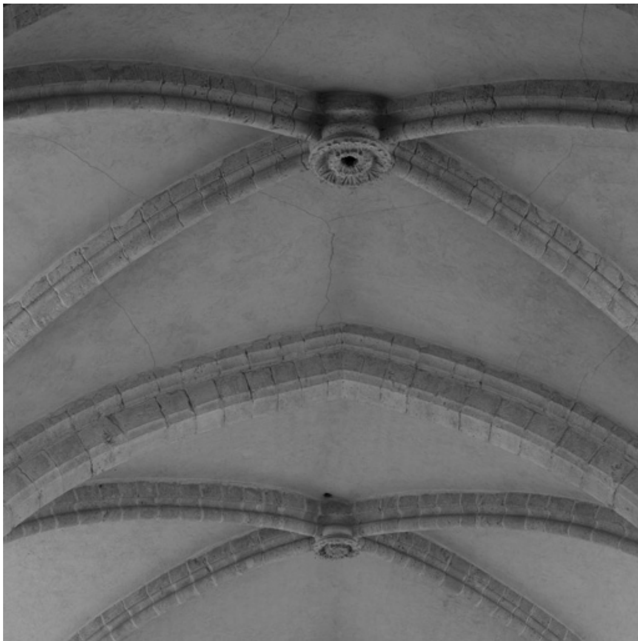
Détail de clefs de voûte de la nef.
