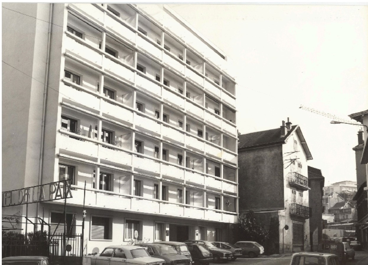
Façade du bâtiment nord, maison Jarrier
